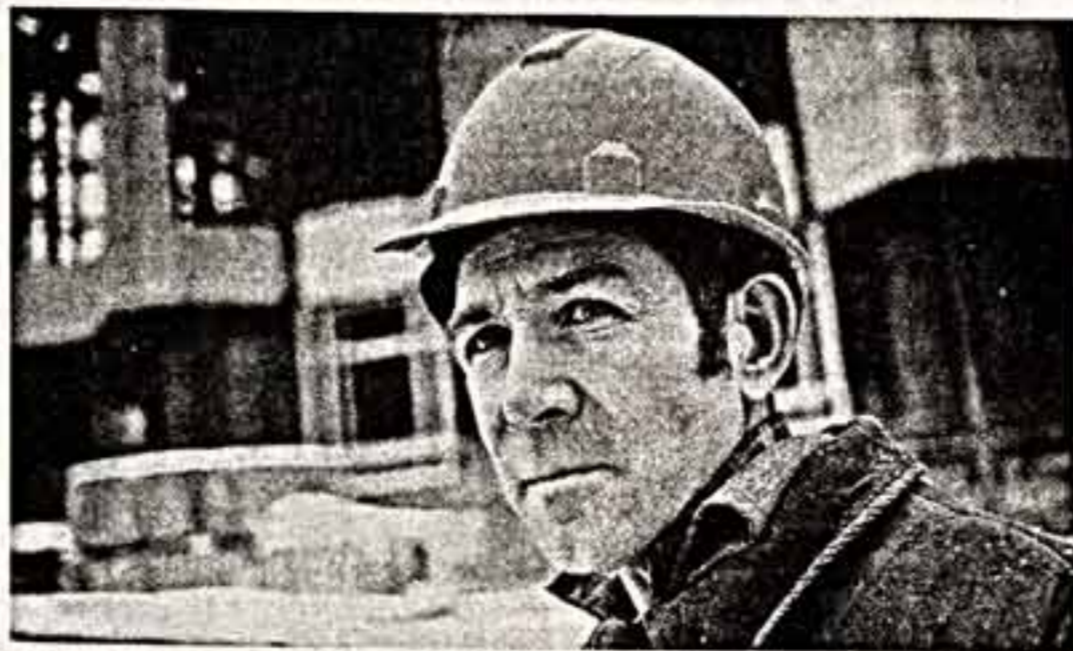
Отлично трудится комплексная бригада, которую возглавляет кавалер орденов Трудовой Славы II и III степеней, депутат Моссовета Виктор Струков. Строители СУ-121 Мосспецкомхоза возводят здание киноцентра на Красной Пресне.
