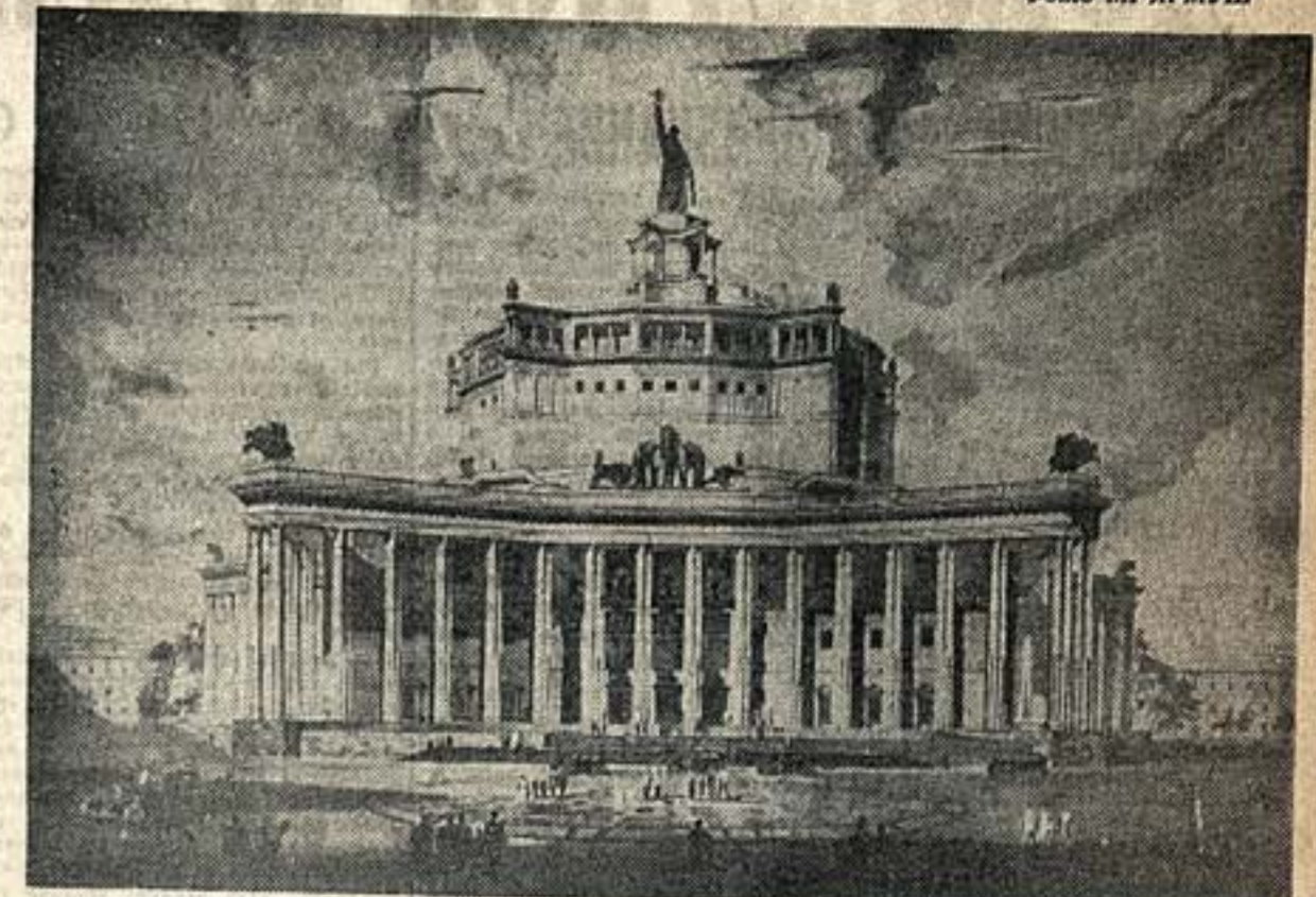
Строится на площади Коммуны здание Центрального театра Красной армии по проекту архитекторов И. С. Алабина и В. Н. Симбирцева
