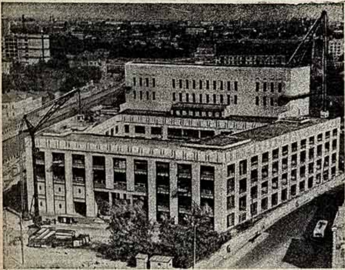
Новое здание библиотеки иностранной литературы в Москве.
