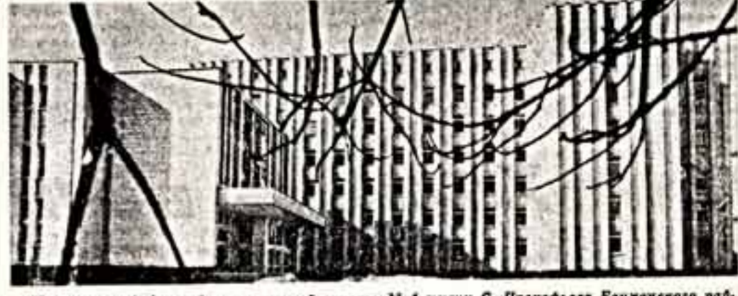
У московской детской музыкальной школы № 1 имени С. Прокофьева Бауманского района — новоселье. Принято в эксплуатацию новое здание, построенное по индивидуальной программе местной мастерской Моспроект-1 специалистами СУ-233 Московского городского объединения жилищного строительства.
