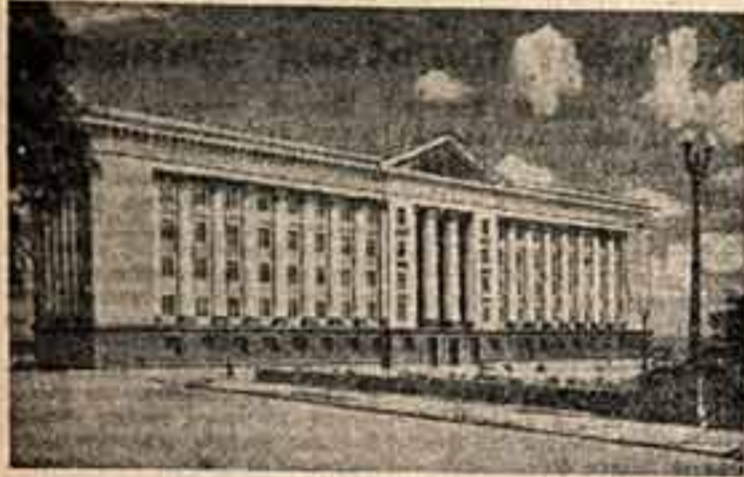
Одно из красивейших зданий Курска — Дом Советов, расположенный на центральной площади города. Строительство Дома Советов было начато еще до Великой Отечественной войны, но немецко-фашистские захватчики разрушили уже возведенные стены здания. После всемирно-исторической победы над фашистской Германией строительство Дома Советов возобновилось и в 1945 году было завершено. Автор проекта Дома Советов архитектор А. Шухалец и главный строитель были премированы на Всероссийском конкурсе на лучшие выстроены здания. На снимке: здание Дома Советов в Курске.
