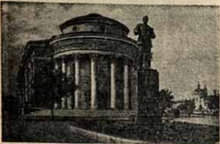
Полностью завершены работы по восстановлению и реконструкции центральной площади г. Орла — площади имени В. И. Ленина. Здесь восстановлены и построены вновь ряд многоэтажных жилых домов и общественных зданий, в том числе здание областного драматического театра (автор проекта арх. Б. Антисин). На площади перед зданием театра воздвигнут памятник В. И. Ленину работы скульптора Н. Томского. На снимке: здание Орловского областного драматического театра на площади имени В. И. Ленина.
