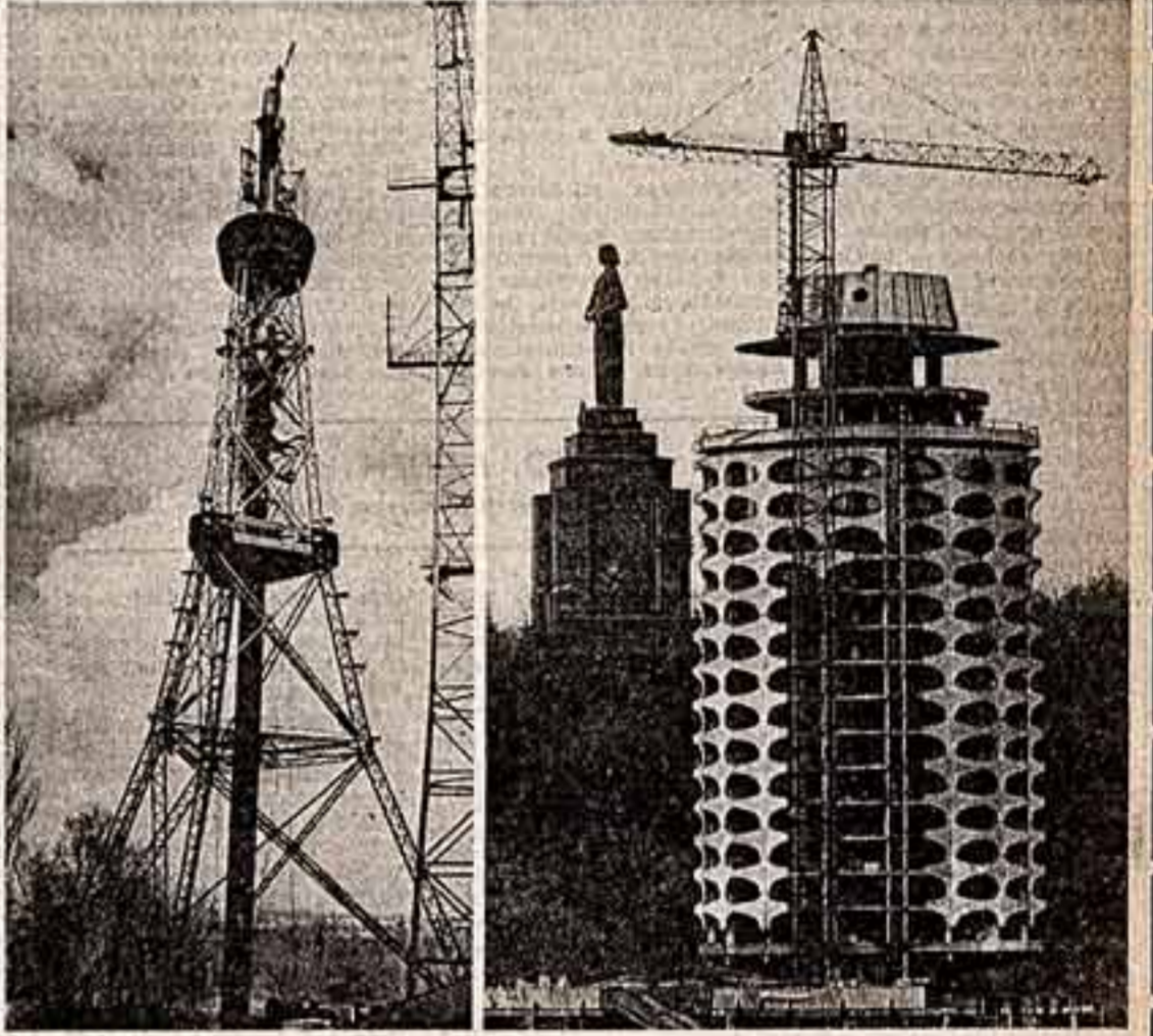
Эти снимки сделаны в столице республики Ереване: новые жилые дома в центре города на улице Мартироса Сарьяна; монтаж новой телевизионной вышки высотой 310 метров; строительство Дома молодежи у подножия парка Победы.
