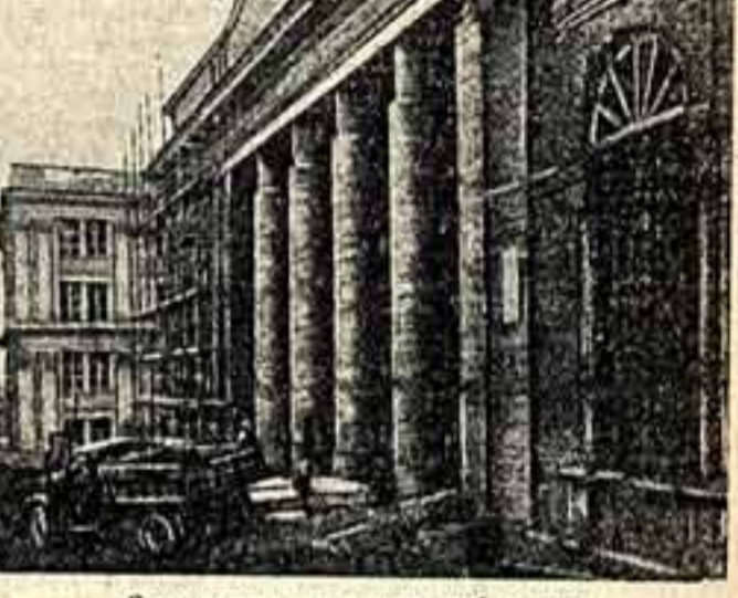
Строится здание картинной галереи.
