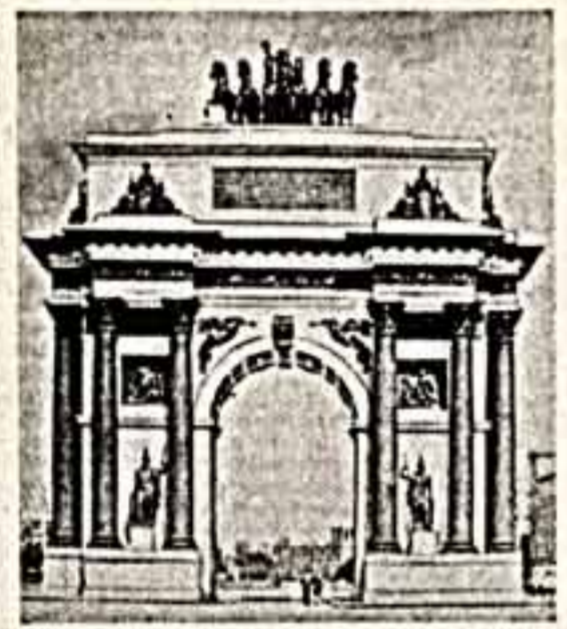
Триумфальная арка. После реконструкции.
