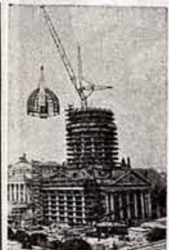
В соответствии с планом реконструкции Берлина на площади Академии ведутся большие работы по реставрации и перестройке этого уникального памятника архитектуры...
