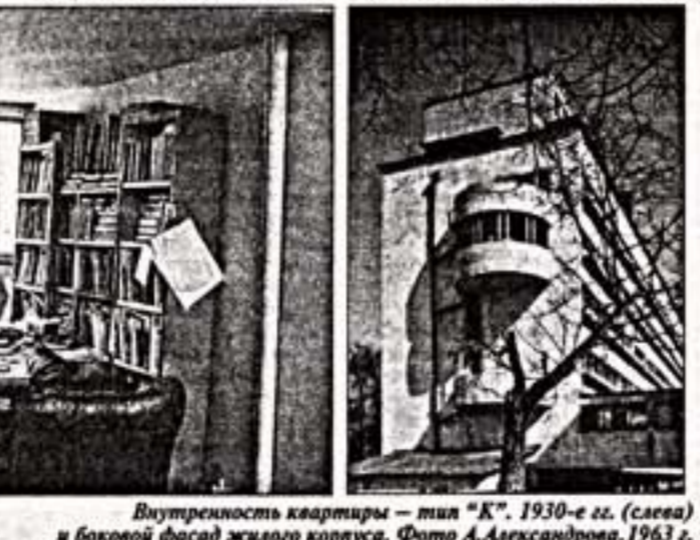
Внутренность квартиры — тип "К". 1930-е гг. (слева) и боковой фасад жилого корпуса. Фото А. Александрова. 1963 г.
