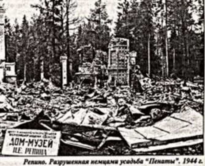
Репно. Разрушенная немцами усадьба "Пенаты", 1944 г.
