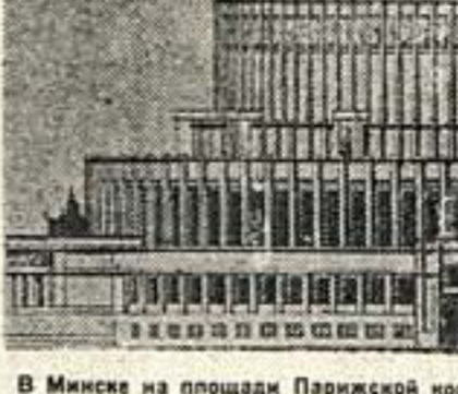
В Минске на площади Парижской коммуны начато строительство здания Большого государственного театра Белорусии. Высота будущего театра 50 метров. Зрительный зал вместит 2250 зрителей. Наряд театр — железобетонный с кирпичным заполнением. Цокольный этаж на высоте 4—5 метров облицован натуральным мрамором. Театр строится по проекту ленинградского архитектора Лангарда. Проект принят жюри правительственного конкурса, объявленного ОНН БССР.
