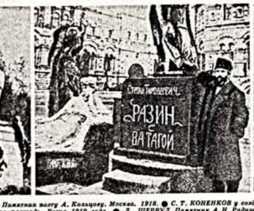
С. СЫРЕЙЩИКОВ. Памятник поэту А. Кольцову. Москва, 1918. С. Т. КОНИКОВ у создателя или памятника Степану Разину. Москва, Красная площадь, Весна 1919 года. Л. ШЕРВУД. Памятник А. Н. Радищеву в Москве, 1918. Л. РУДНИКОВ. Памятник борцам Революции на б. Марсовом поле в Петрограде, 1918—1920. Н. ВСЕВОЛОЖСКИЙ. Обелиск революционным мыслителям в Александровском саду, Москва, 1918.
