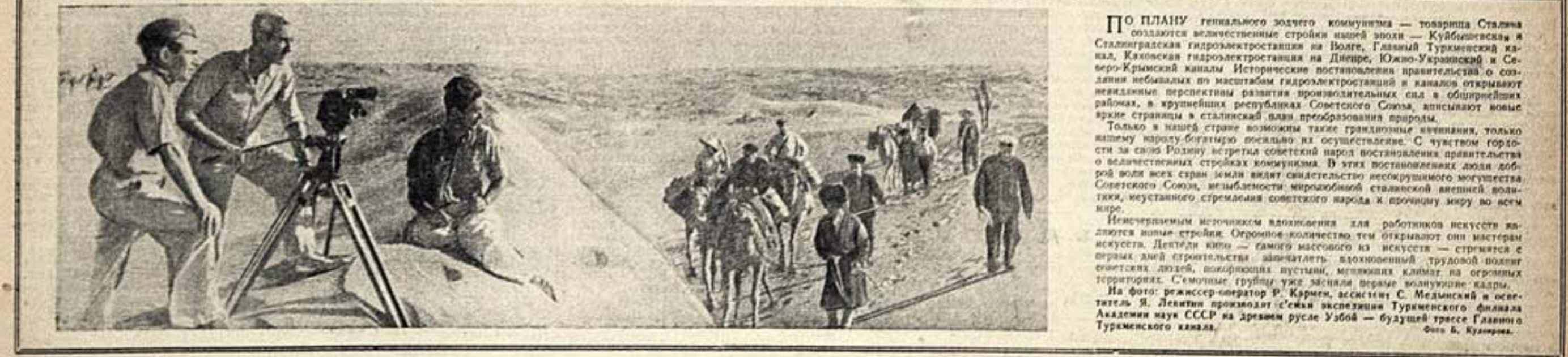
По плану генерального завода коммунизма — товарища Сталина созданы величайшие стройки нашей эпохи — Куйбышевская и Сталинградская гидроэлектростанции на Волге, Главный Туркменский и Северо-Крымский каналы. Историческое постановление правительства о создании небывалых по масштабам гидроэлектростанций и каналов открывает невиданные перспективы развития производственных сил в обширнейших районах, в крупнейшей республике Советского Союза, а также новые тропы страны в сталинском деле преобразования природы.
