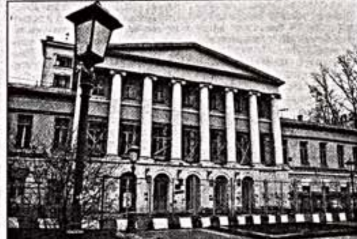
Музыкальный колледж имени Гнесиных нуждается в реконструкции
