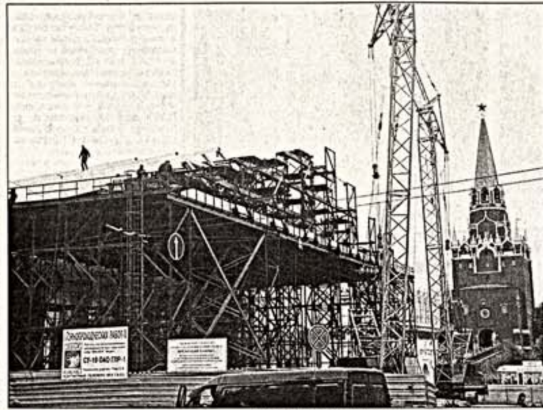
Работы по реконструкции Манежа идут полным ходом
