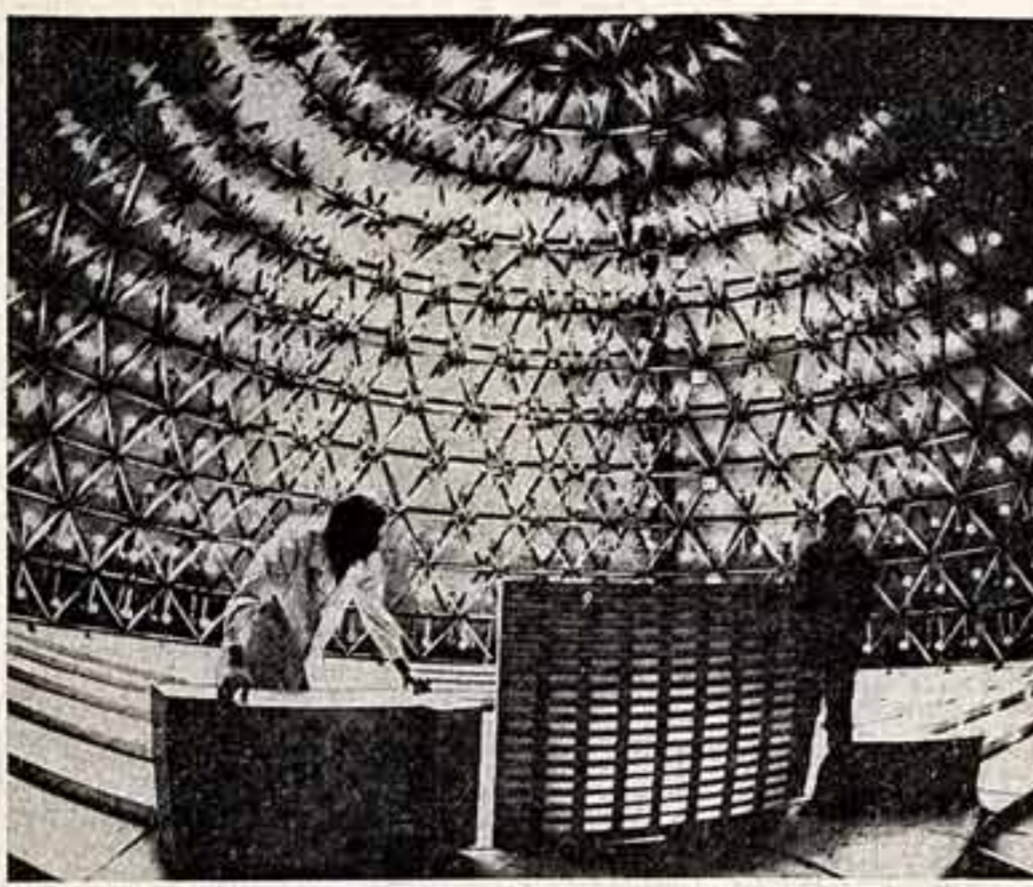
«Искусственный небосвод» — так называется новое оригинальное сооружение, предназначенное для архитекторов и проектировщиков, рассчитывающих нормы естественного освещения в жилых и служебных помещениях. Инженер Н. Павлов и техник П. Тало проводят эксперимент по определению оптимальной освещенности зданий при жакетах. Фото В. Чайкиных.
