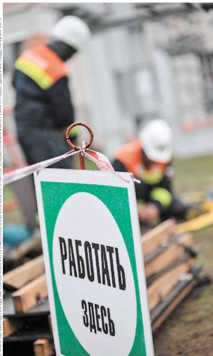
В. ХАБАРОВ. «МЕЖДУНАРОДНЫЕ СОРЕВНОВАНИЯ ПРОФЕССИОНАЛЬНОГО МАСТЕРСТВА ПО ТЕКСТИЛЬНОМУ РЕМЕСЛУ И РЕМОНТУ ОБОРУДОВАНИЯ ПОДСТАНЦИЙ», 2013
