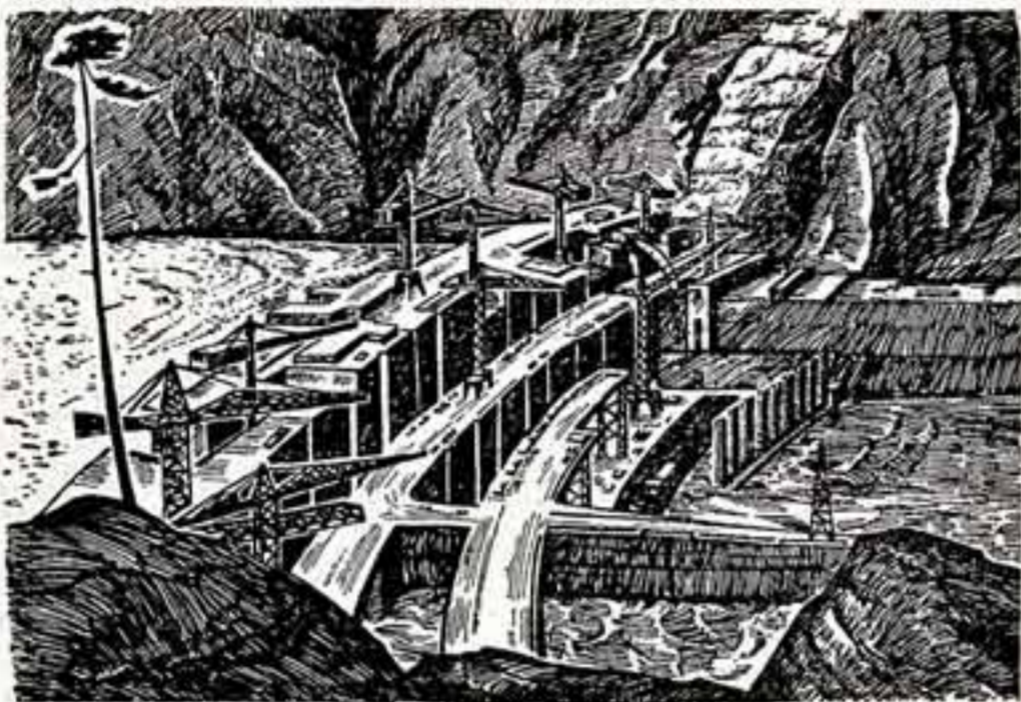
Сакребульская ГЭС — всеобъемлемая ударная комсомольская стройка. Со дня пуска первого агрегата по январю этого года ГЭС уже выдала 5 миллиардов киловатт-часов электроэнергии в Единую энергетическую систему Сибири. Эксплуатационники обещают дать в съезду партии еще 80 миллионов киловатт-часов электроэнергии.
