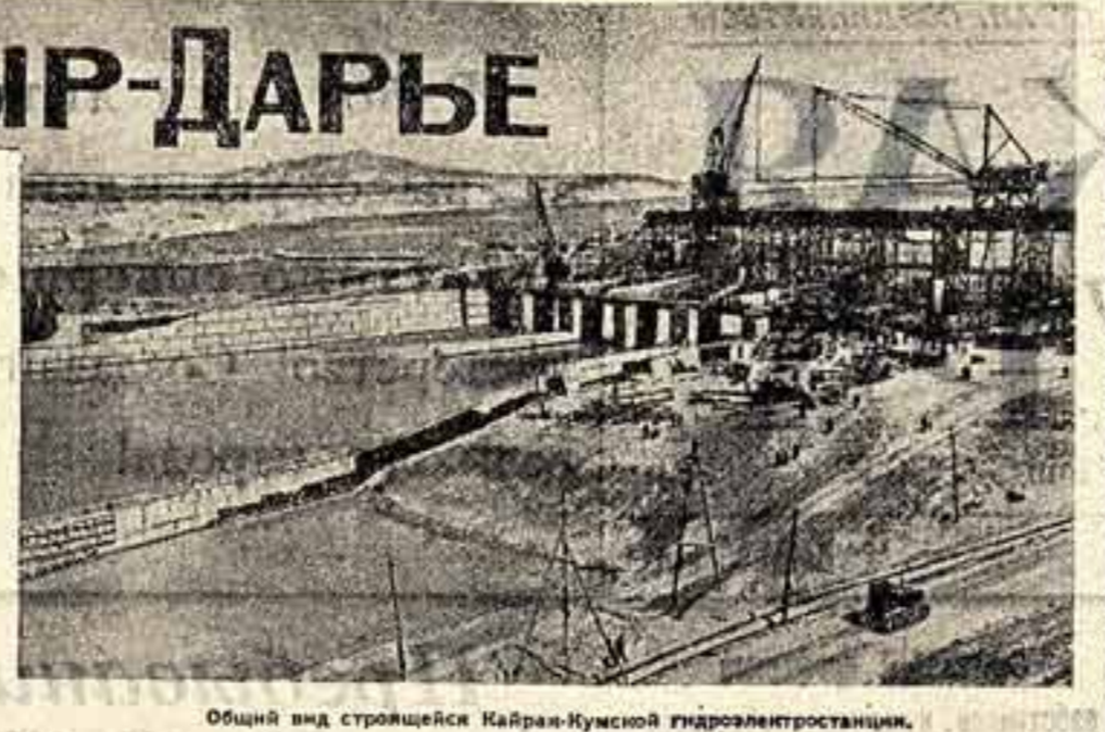
Общий вид строящейся Кайрак-Кумской гидроэлектростанции.
