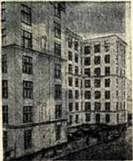
Виды бронзой дворь и большие ажурные с богатым орнаментом часы, выходящие главным фасадом, обогатят фасаду стены, не нарушая ее строгой простоты. Хорошее впечатление производит светозеркальный золотистый тон керамической облицовки и окрашенные в тот же цвет железобетонные декоративные элементы.
