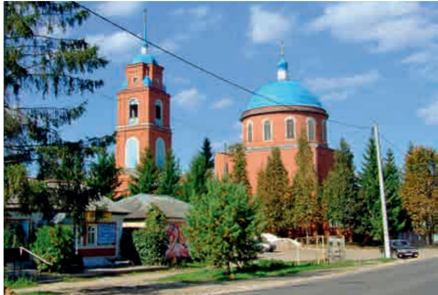
Исторический центр Одоева — храм Троицы Живоначальной
