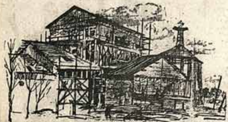
Постройка новой сцены в Большом драматическом театре парка И.О.
