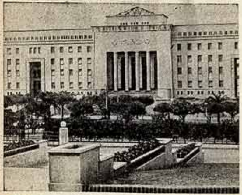
Объединенная Арабская Республика (Египетский район). На снимке: здание инженерного факультета Александрийского университета. Фото Управления информации Египетского района ОАР.
