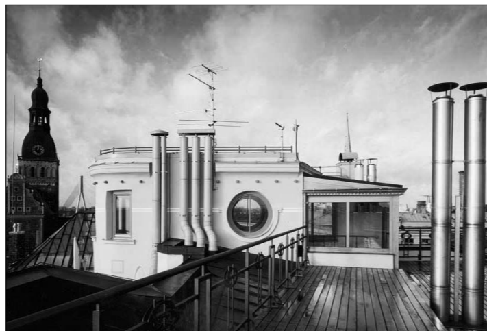
Реконструкция здания ар нуво, терраса, старая Рига
