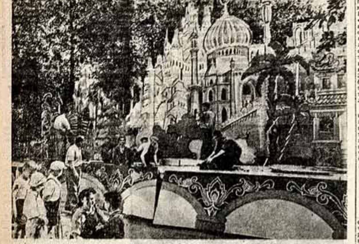
Симонный город... Он строится на Тверском бульваре по проекту художницы Н. Горюхиной и архитектора Д. Платонова и П. Добровольского.
