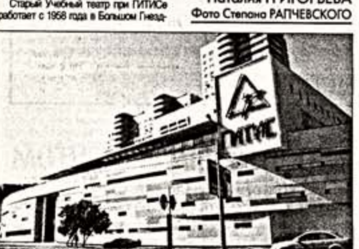
Новое здание на улице Академика Пилупина
