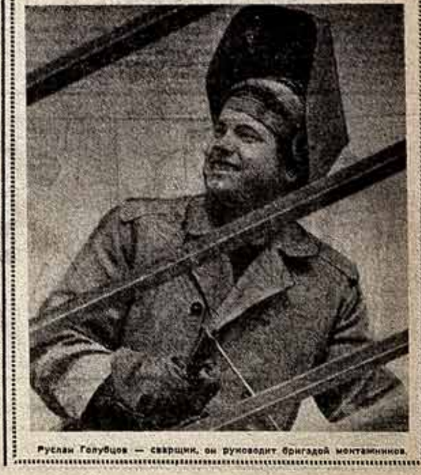
Руслан Голубцов — вверху, он руководит бригадой монтажников.
