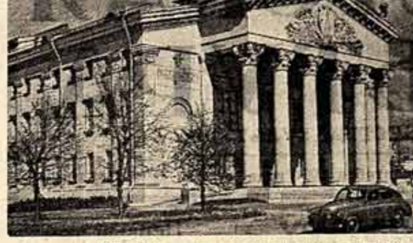
Белорусская ССР. В Гомеле заканчивается строительство здания Русского областного драматического театра. Сейчас идут последние отделочные работы внутри помещения. На сценке: Русский областной драматический театр. Фото М. Миклошевич (ТАСС).
