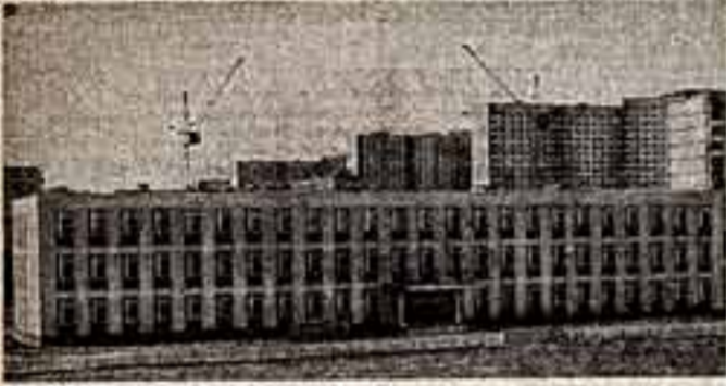
Так выглядит школа-новостройка № 790 в микрорайоне Ясенево. Около тысячи ребят сидят здесь за партами 1 сентября.
