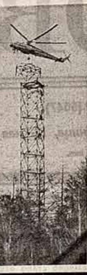
Вертолет ведет монтаж.
