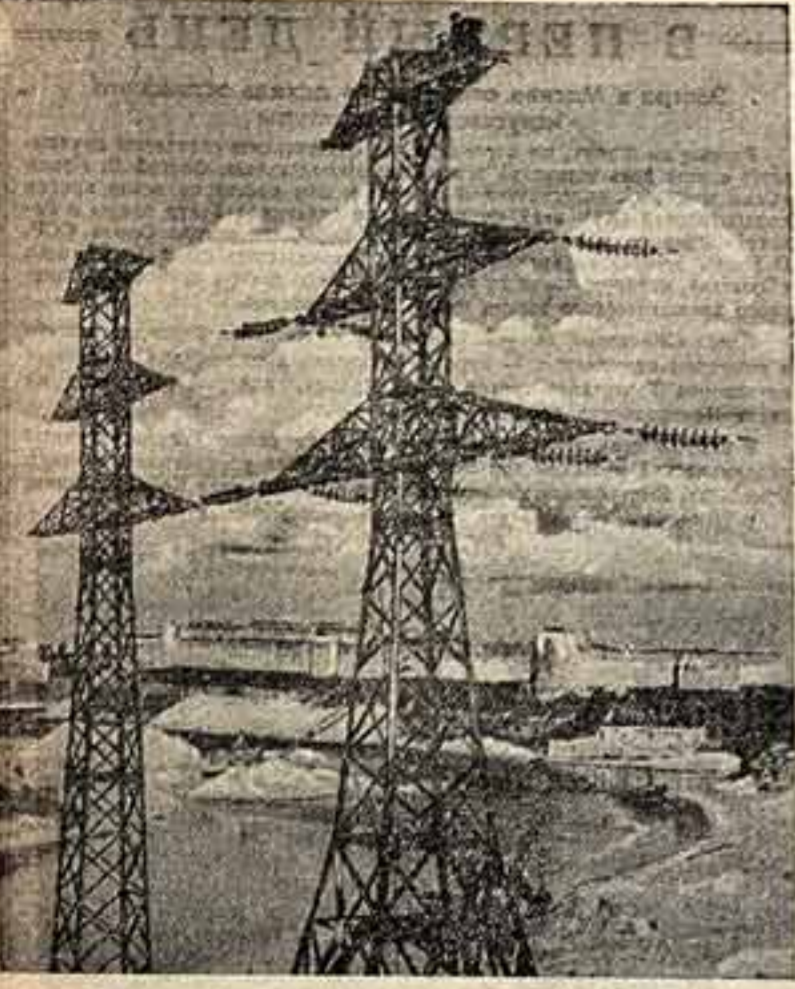
Высоковольтная линия электропередачи Нарской ГЭС. Фото А. РАТСЕПА.
