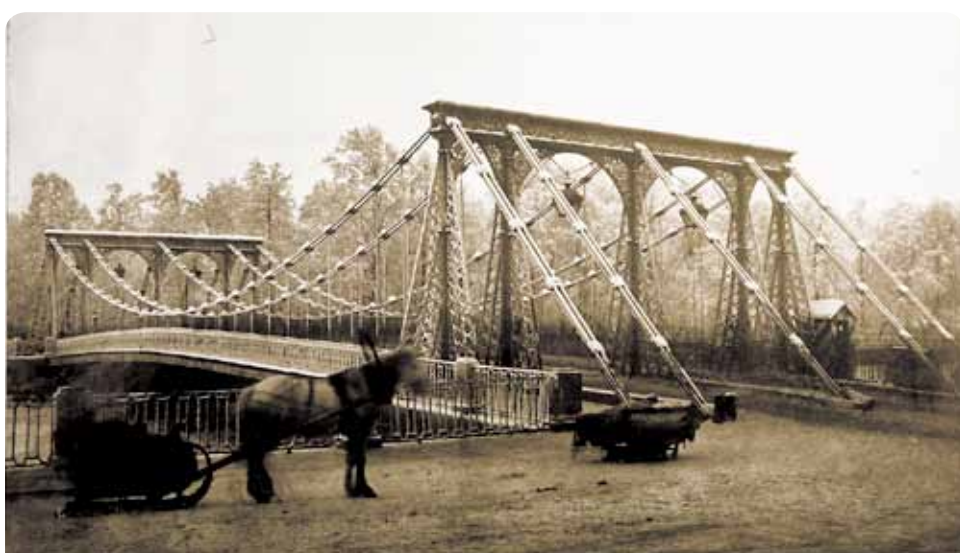
САНКТ-ПЕТЕРБУРГ. ПЛАТЕЙСКИЙ МОСКОВСКИЙ МОСТ. 1853
