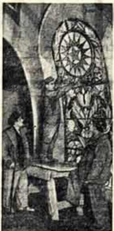
Установка одного из 32 витражей на станции метро «Новослободская»...
