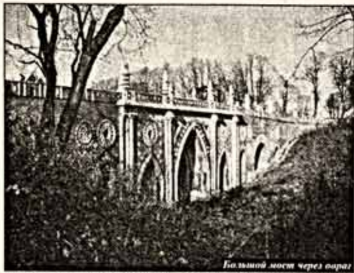
Большой мост через овраг
