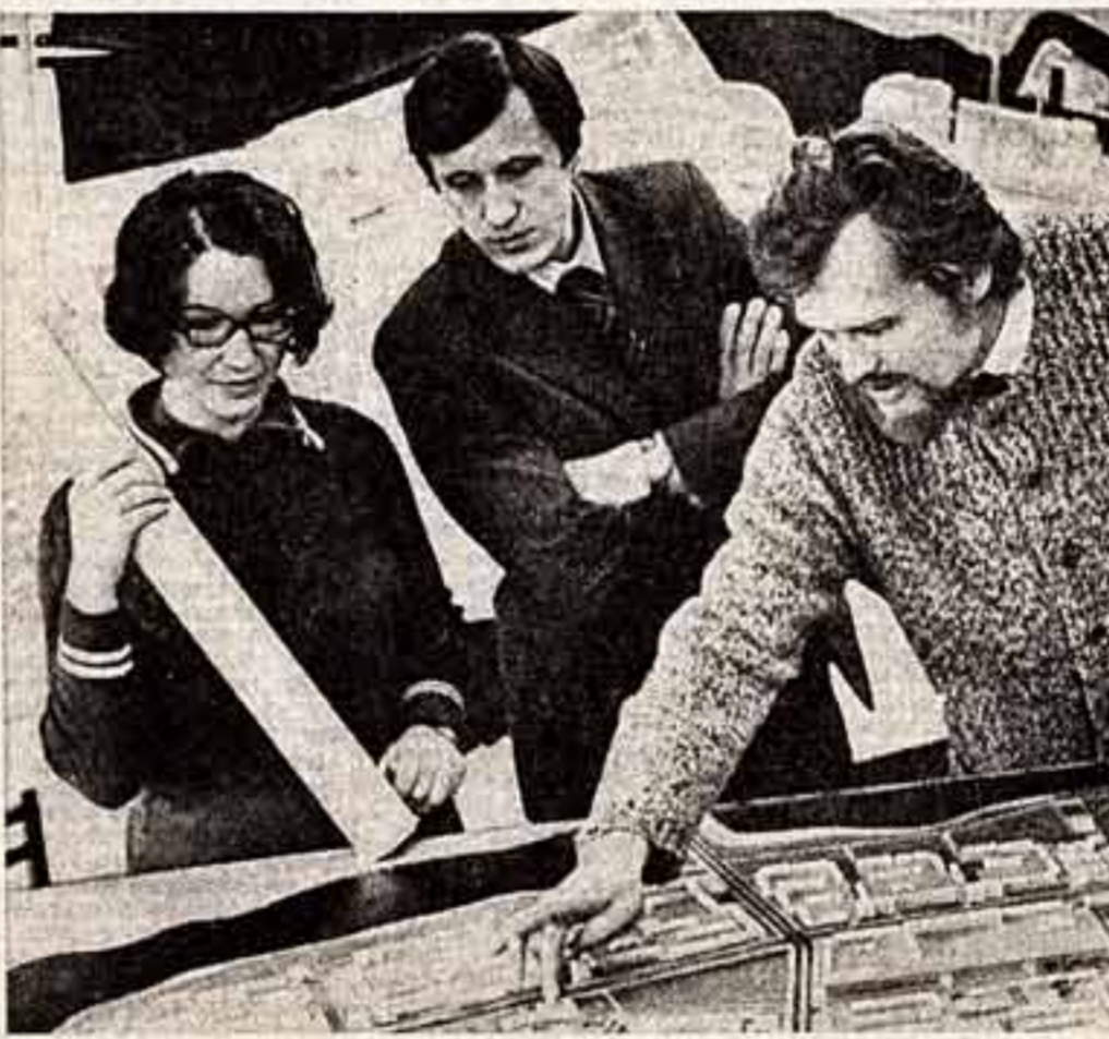
Растет и хорошеет город автомобилестроителей Ижевске Чельмы. Строительство ведется по генеральному плану с высокой степенью благоустройства. * Архитекторы «Гатражданпроекта» М. Балта, Г. Вирков и В. Вацунов обсуждают проект застройки нового жироайрона города.
