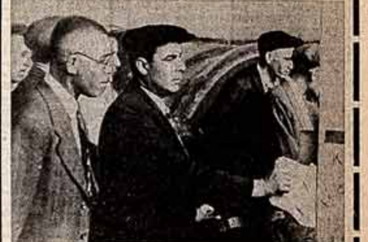
Запорожье, 1947 год. Л. И. Брежнев (в центре) в период восстановительных работ на заводе «Запорожсталь».
