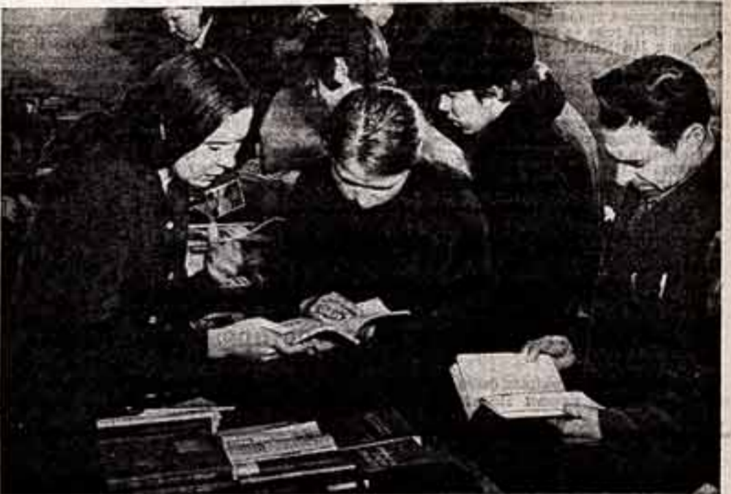
Горький. Рабочие и специалисты цеха обработки и укомплектовки запасных частей Горьковского автомобильного завода...
