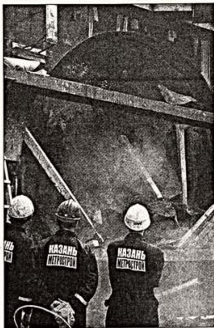
На строительстве метро в Казани
