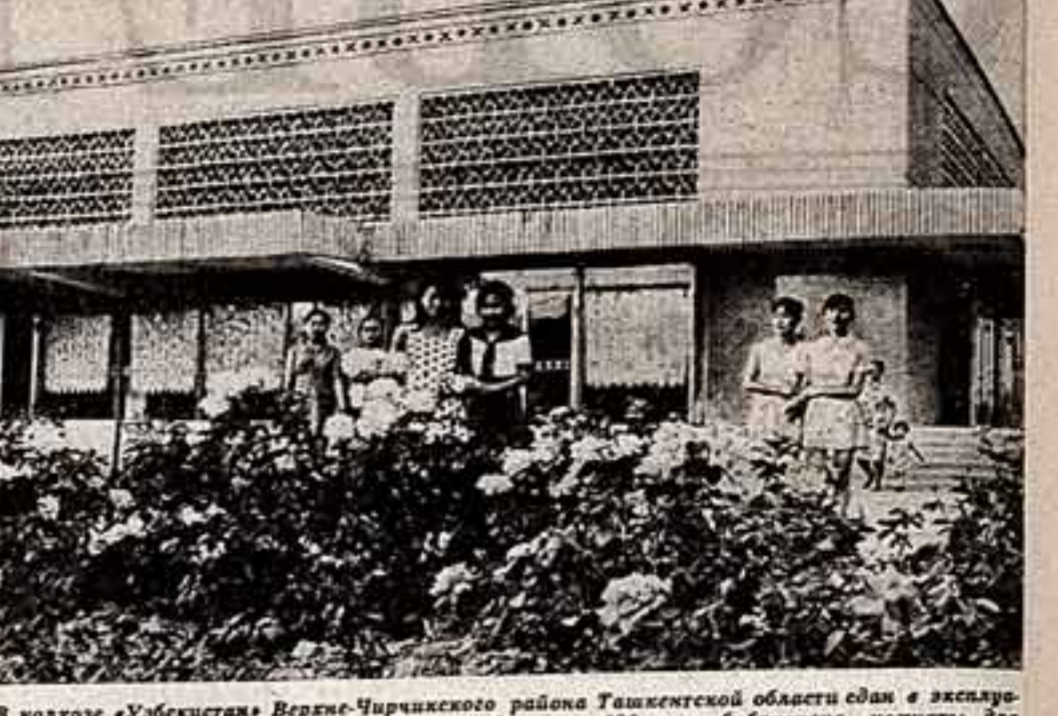
В колхозе «Узбекистан» Верхне-Чирчикского района Ташкентской области дом в эксплуатацию. В здании — зрительный зал на 600 мест, библиотека, комнаты для работы кружков, зал для проведения семейных вечеров. Вокруг дворца разбит сквер. Прелесть колхоза выдвинула для строительства и оборудования дворца миллион рублей. Фото Г. Пуна (ТАСС).
