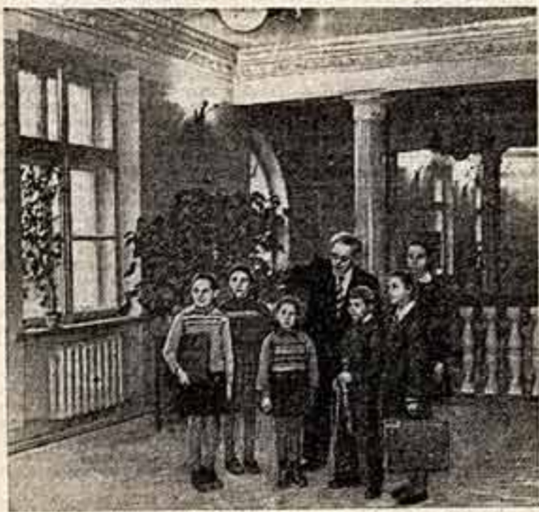
Заведующий учебной частью Я. Синельников знакомит учащихся с новым зданием.
