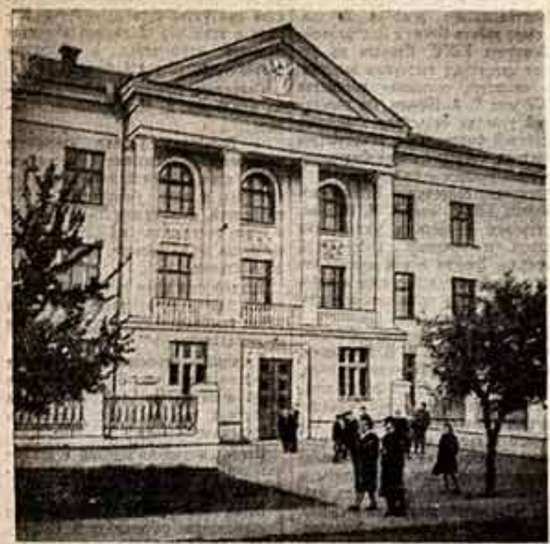
Киров. Дом, Здание Кировской детской музыкальной школы, сооруженной в этом году. Фото И. СЕЛЮЧЕНКО (ТАСС).
